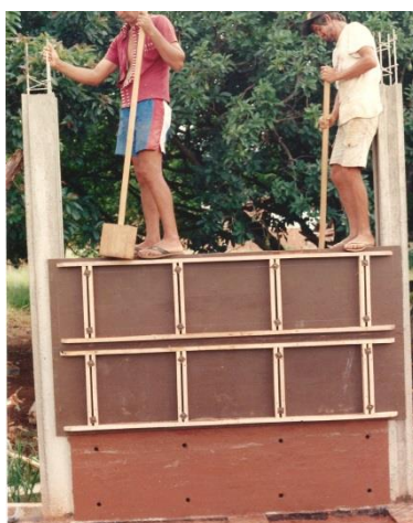
Figura 10 – Exemplo de parede monolítica com solo-cimento
