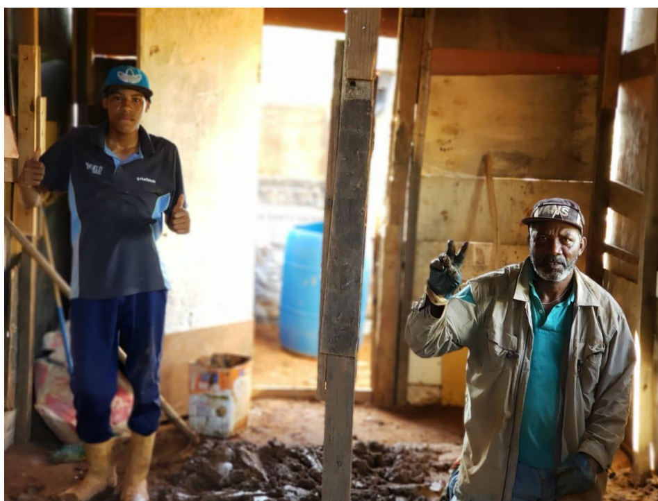
Figura 21 – Construção de novo barraco
