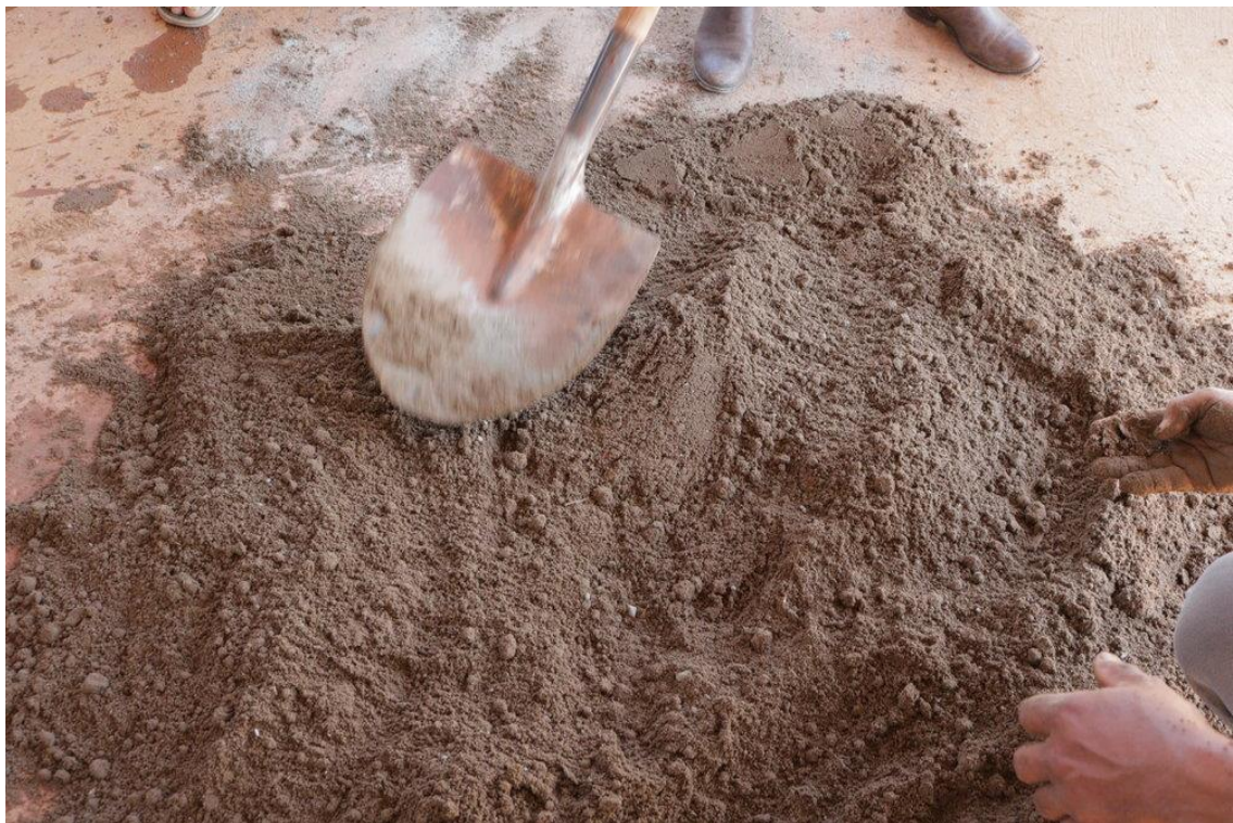
Figura 45 – Processo de destorroamento
